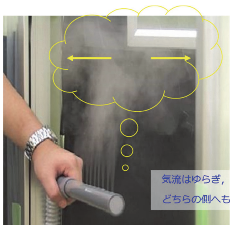
写真3. 解放された扉付近でスモークを焚いた様子
