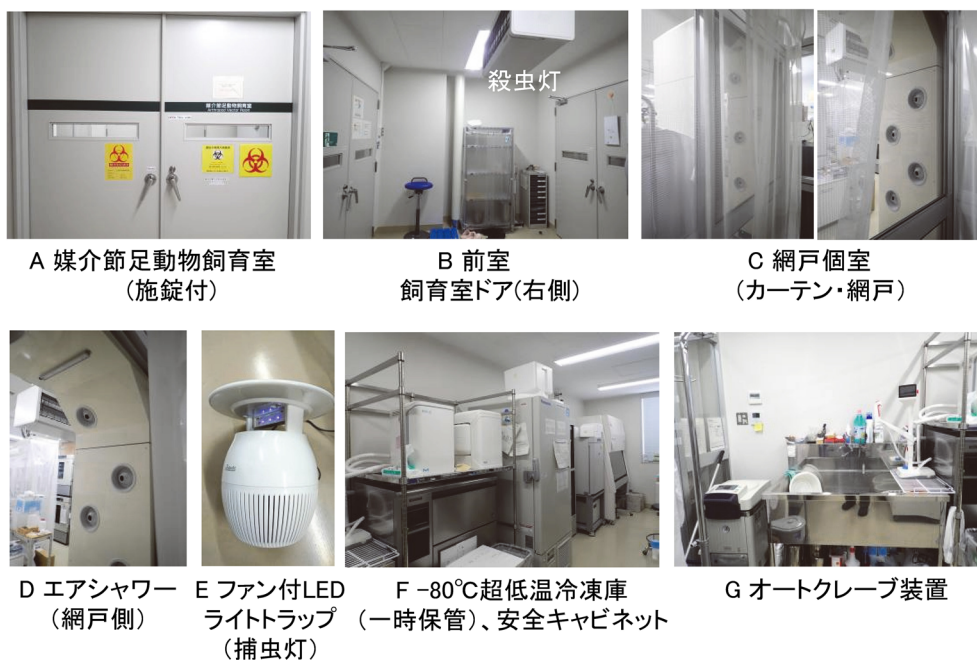
写真 1. 媒介節足動物飼育室の逃走防止設備
